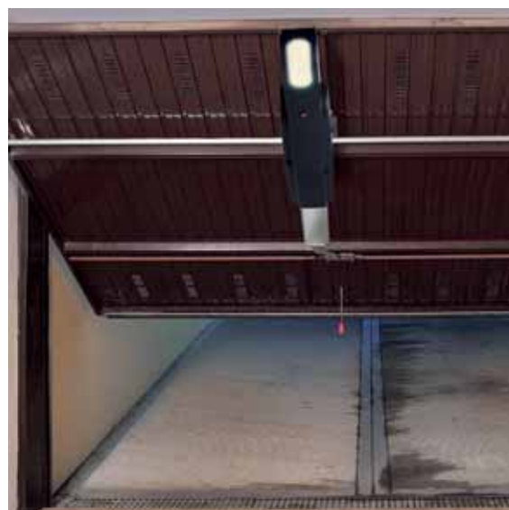
1. attuatore FAAC 550/RP 433 DS scheda ricevente
